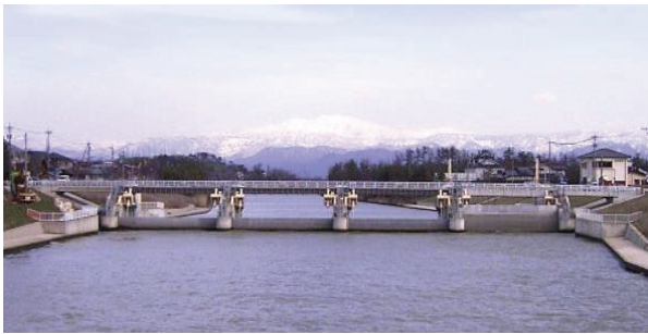
新堀川潮止水門 全景（写真①）
